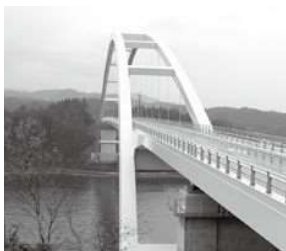
昨年4月に開通した「気仙沼大島大橋」
