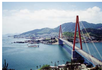
▲麗水 突山大橋
