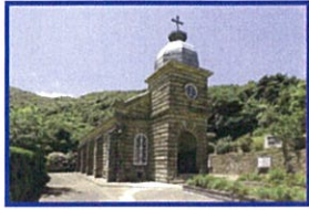
頭ヶ島天主堂（新上五島町）
