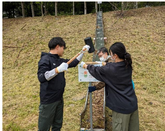
・看板設置作業の様子
