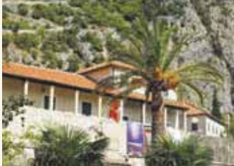
建物の直ぐ裏に急な崖が迫っています
