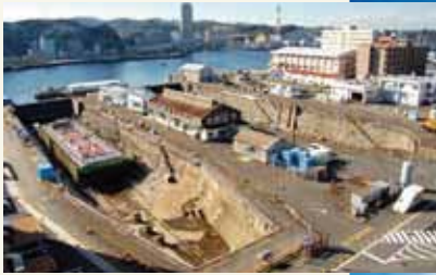
1871年(明治4年)に完成した1号ドックは日本最古にして現役のドライドック(艦船の修理施設)※見学は不可
