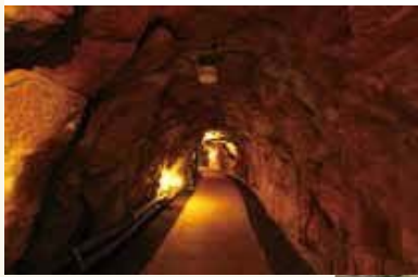
総延長は350km、深さは地下880mに達した生野銀山の坑道
