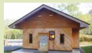
野営場内トイレ
