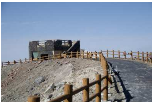
Dゾーンにある展望所。一階は退避壕として利用。2階が展望フロア。仮復旧なので階段等に注意。通路、安全柵は復旧済み。
