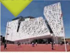
光触媒素材を使ったイタリア館の建物。大気中の一酸化窒素や窒素酸化物を吸収して不活性塩に変え、屋根で発電も(写真:地球の歩き方)
