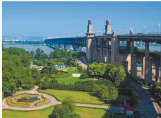
その完成により北京と上海を鉄道で直結した南京長江大橋
