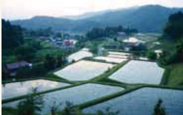
砂鉄を採取した跡地は棚田となり、ブランド米や蕎麦を産出しています
