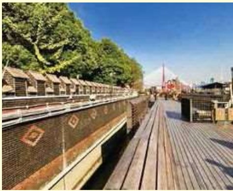
沿岸に歩行者専用道路も敷設された外滩(上海)
