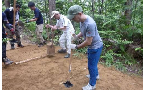
土を入れ均す
