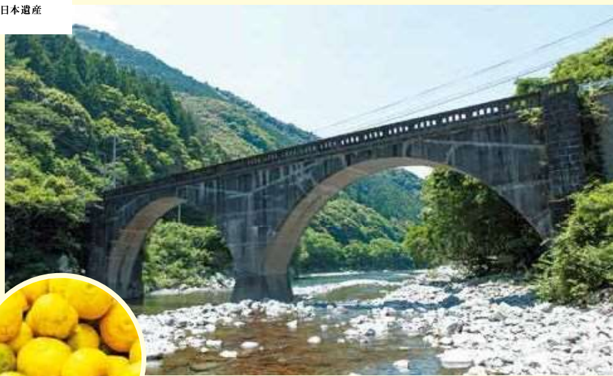
魚梁瀬森林鉄道「二股橋」。
