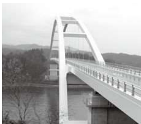
昨年4月に開通した「気仙沼大島大橋」
