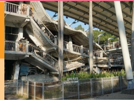
1999年台湾中部で発生した大地震の断層のずれ、校舎の倒壊、河床の隆起などをそのまま保存
