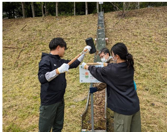
・看板設置作業の様子
