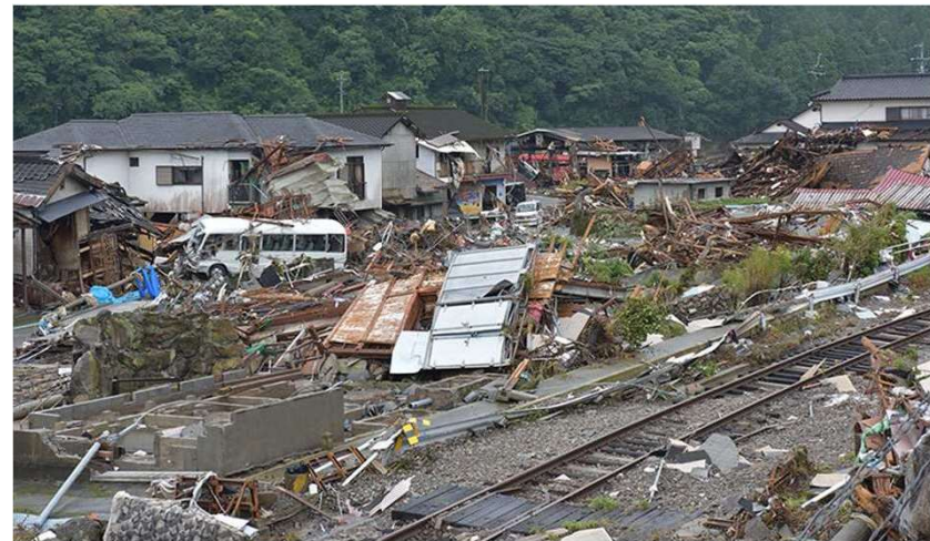
氾濫による被害の様相（球磨村渡地区）
