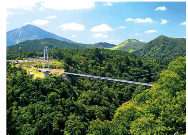
九重 夢 大吊橋
