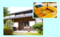
内装を改修した農家民宿 (岡山県吉備中央町)
