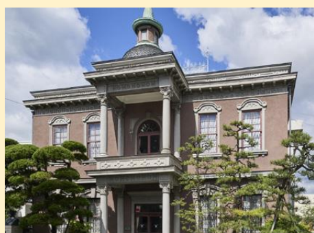
城西浪漫館(中島病院旧本館)
