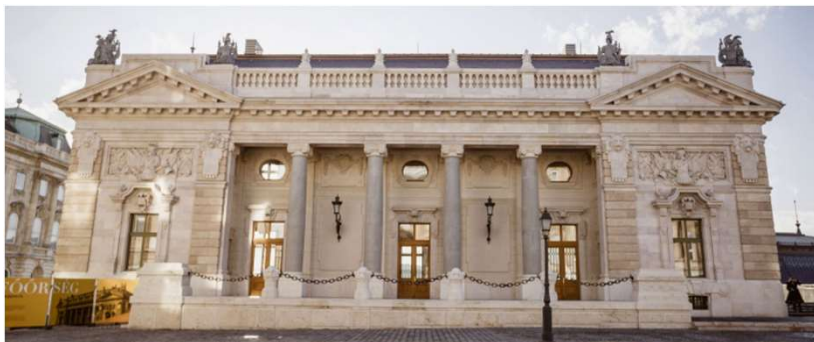
再建された衛兵詰所
